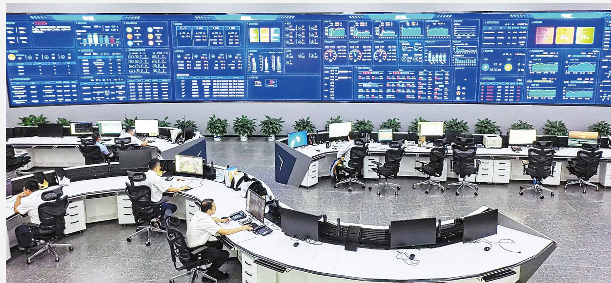
▶ 智慧运营管控中心
