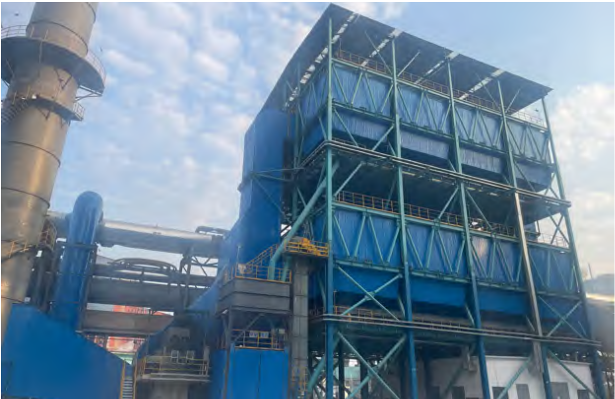
高爐熱風爐煙氣脫硫項目
